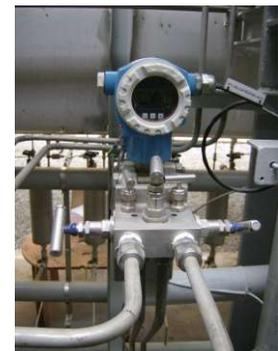
La medición de la diferencia entre dos presiones permite determinar el caudal volumétrico de líquido o gases, medir el nivel de líquido, pastas, jugos, petróleo en tanques, etc, o comprobar el estado de un filtro, adecuando el elemento primario al tipo de producto.
