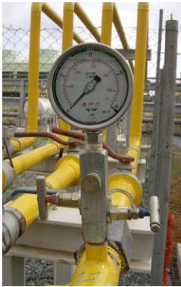
Moderna forma de instalar un manómetro, la válvula de cierre y purga provee la posibilidad de calibración o purga y de montaje horizontal
