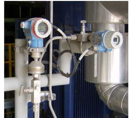
Con el avance de la electrónica, el transmisor se convierte en el elemento clave en el control automático, una válvula de cierre y purga o un manifold de 2 válvulas son necesarios para una adecuada instalación, que permitiera retirarlo para calibrar o hacerlo in situ.
